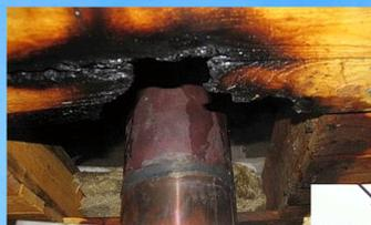
Соблюдать нормы противопожарной разделки (отступки) от горючих конструкций.
